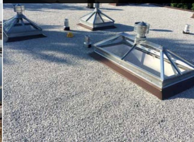
Устройство неэксплуатируемой кровли
