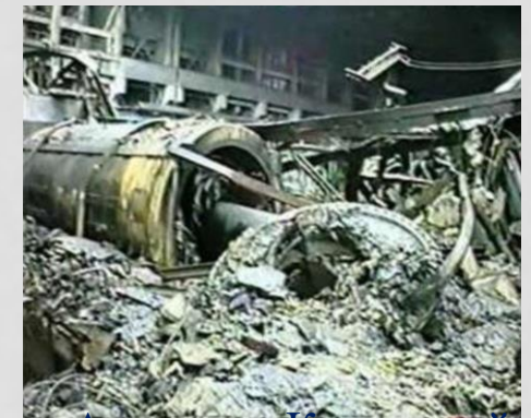
Авария на Каширской ГРЭС-4, 2002
