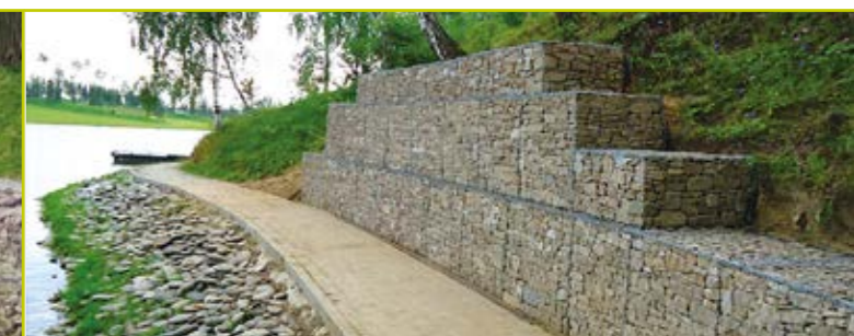
Данная система может использоваться при проектировании гидротехнических сооружений, т.к. благодаря водопропускной способности, габионы не испытывают гидронагрузки.
