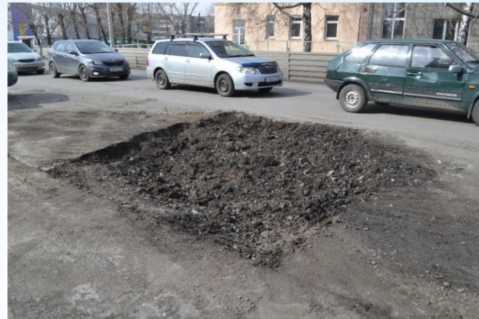
Засыпка провалов, Барнаул
